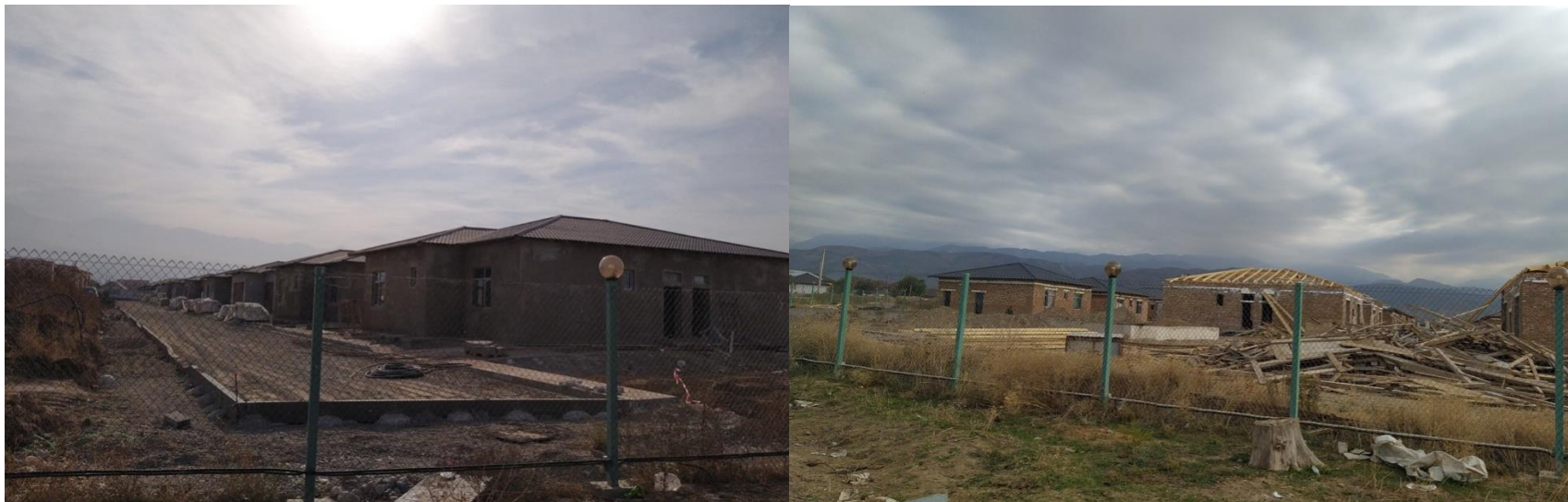
Рисунок Б.2- Этапы строительства образцового одноэтажного жилого дома в Алматинской области
