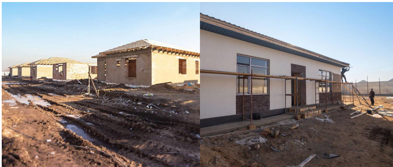
Рисунок Б.3- Этапы строительства образцового одноэтажного жилого дома в Алматинской области
