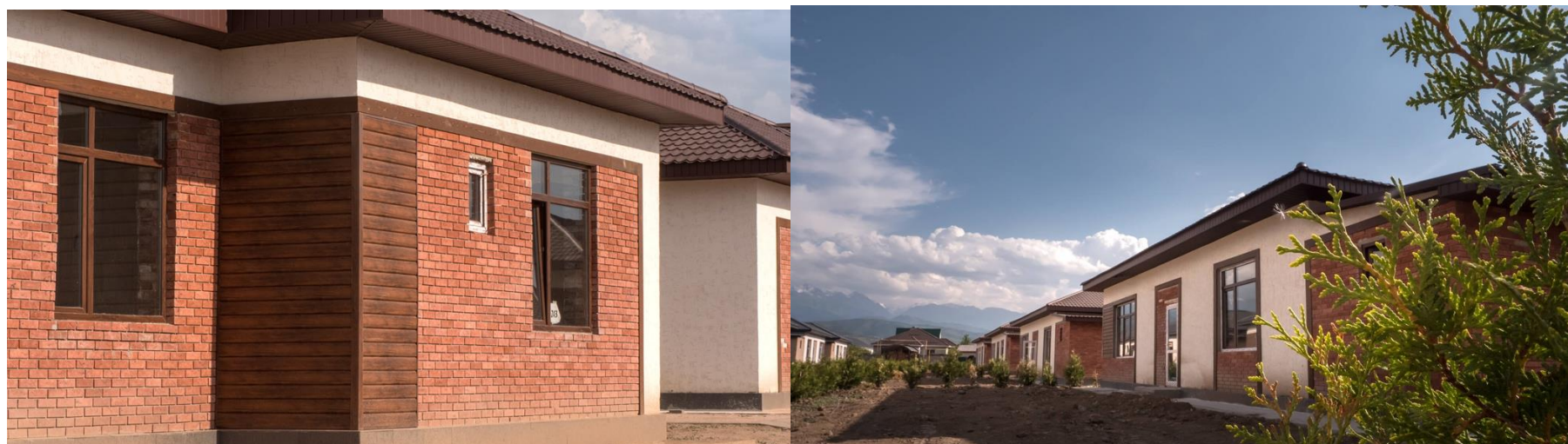
Рисунок Б.4- Заключительный этап строительства образцового одноэтажного жилого дома в Алматинской области
