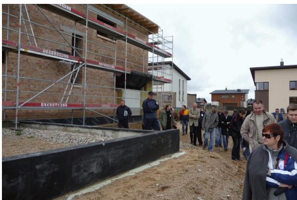
Рисунок 9 - Учебный семинар на стройплощадке возведения конструкций энергоэффективного жилого здания в Вильнюсе
