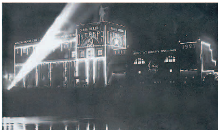
Рисунок А. 56 – Электростанция на Раушской набережной, Москва, Россия, 1927
