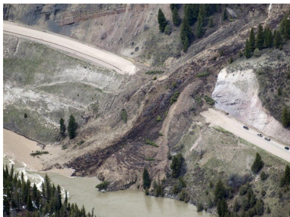
Рисунок 1.8-Сползание грунтов у обочин автомобильной дороги при Исфара-Баткинском землетрясении 1977г.
