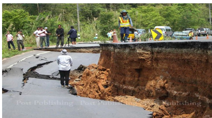
Рисунок 1.12-Оседание дороги в Непале составило более двух метров
