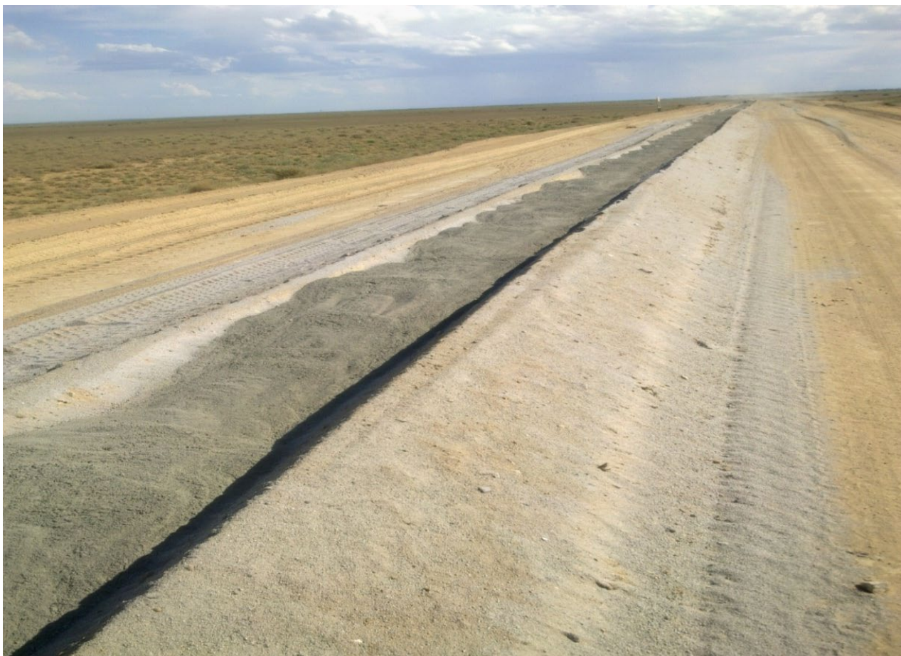
Рисунок 5.1 - Валик из укатанных наноструктурированных бетонов из шлакового белитового вяжущего материала основания перед его профилированием и фрезерованием
