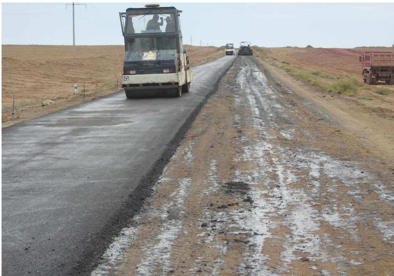
Рисунок 5.4 - Уплотнение уложенного слоя асфальтобетонного покрытия сверх укатанных наноструктурированных бетонов из шлакового белитового вяжущего основания автомобильной дороги «Шиели-Тойконур»
