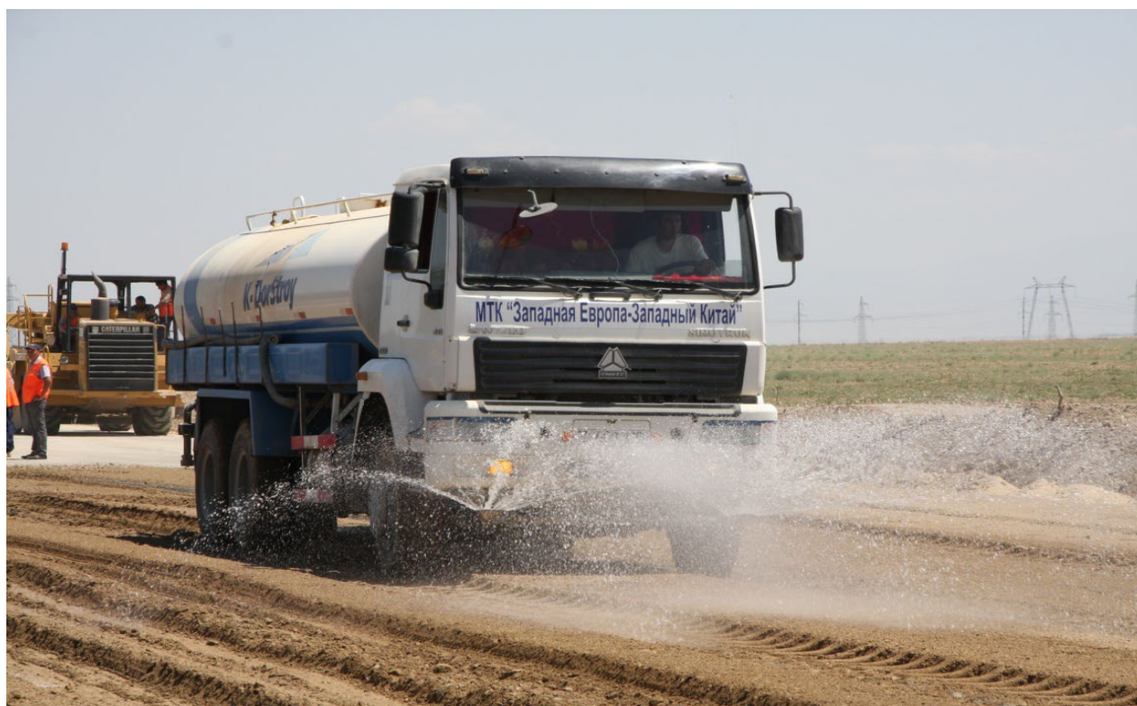
Рисунок 5.2 - Внесение водного раствора химического стабилизатора «Полибонд»; в смесь укатанных наноструктурированных бетонов из шлакового белитового вяжущего
