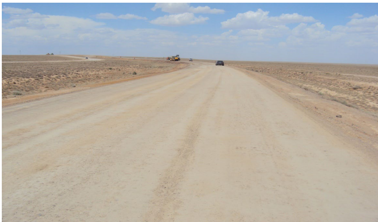
Рисунок 5.3 - Общий вид уплотненной смеси укатанных наноструктурированных бетонов из шлакового белитового вяжущего основания
