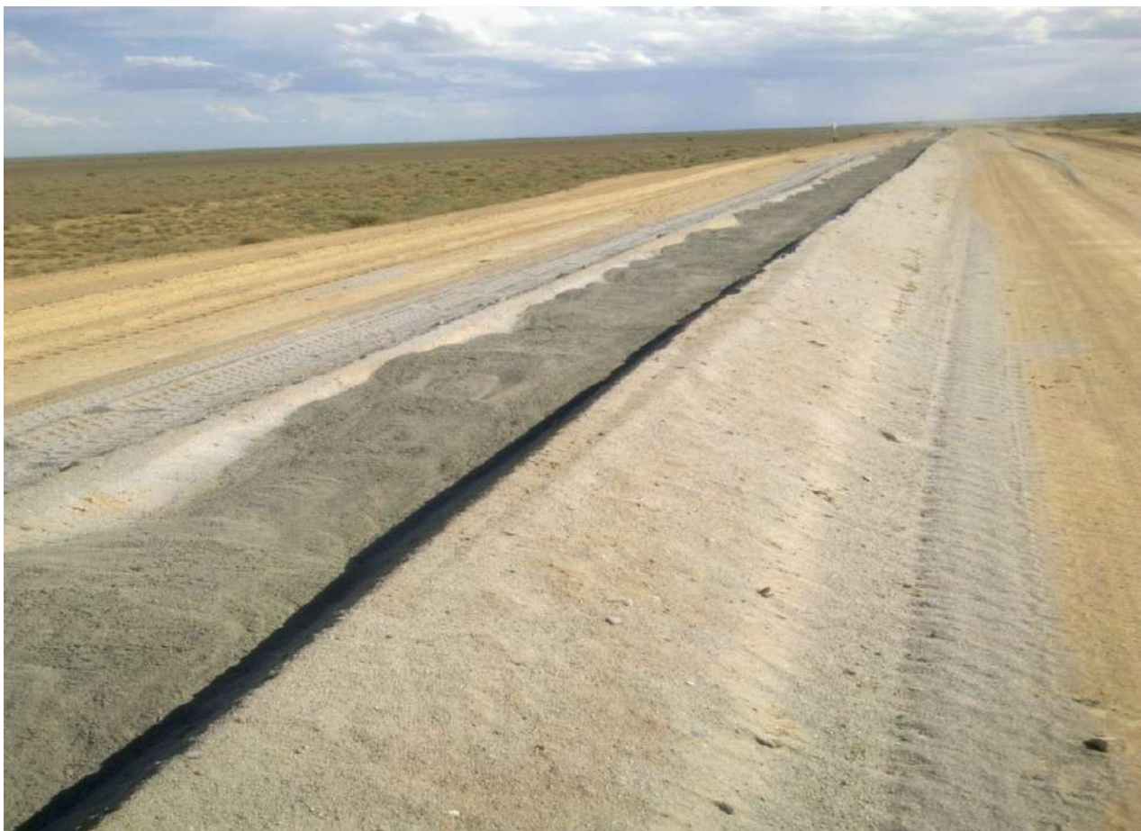
Рисунок 5.1 - Валик из укатанных наноструктурированных бетонов из шлакового белитового вяжущего материала основания перед его профилированием и фрезерованием
