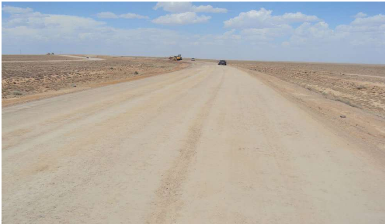
Рисунок 5.3 - Общий вид уплотненной смеси укатанных наноструктурированных бетонов из шлакового белитового вяжущего основания
