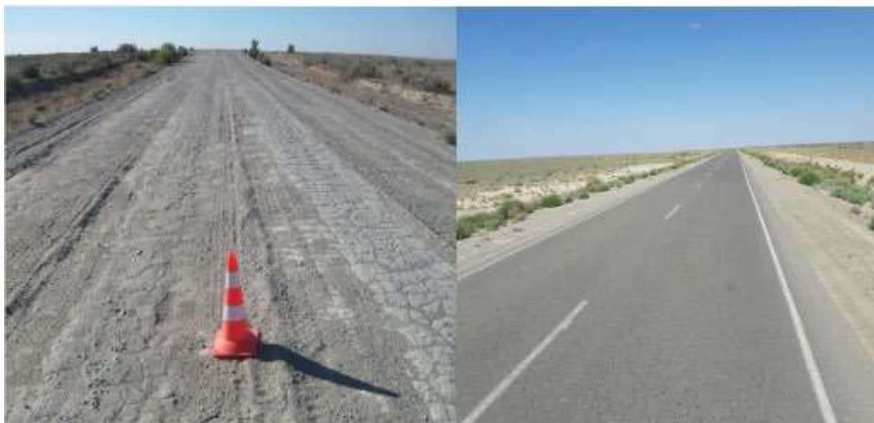
Рисунок 5.5 - Реконструкция дороги «Шиили-тойконур» протяженностью 150 км. Методом холодного ресайклинга с использованием укатанных наноструктурированных бетонов из шлакового белитового вяжущего
