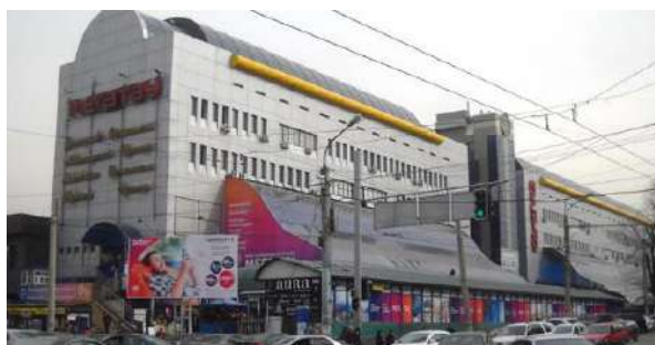
Рисунок 4 – Дом быта после реконструкции [3].
