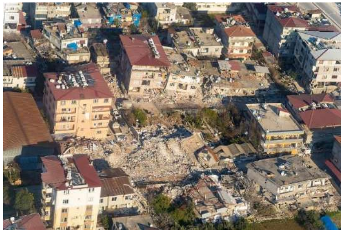
Рисунок 5 – Разрушенные здания в турецкой провинции Хатай
