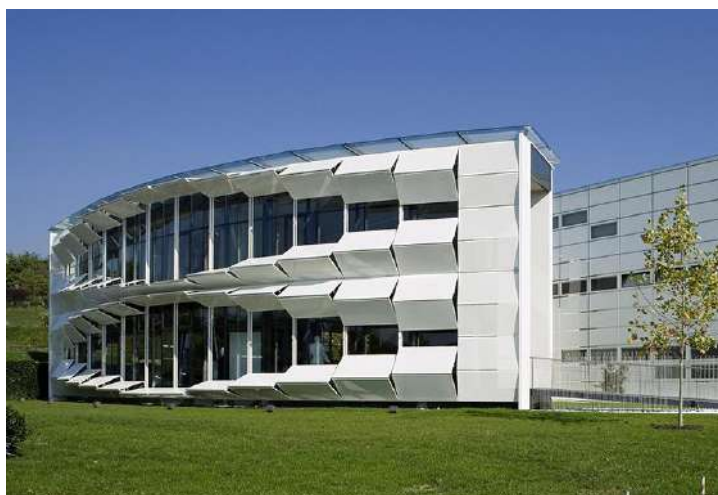
Рисунок 2 – Офисное здание в Бад-Глайхенберге, Австрия
