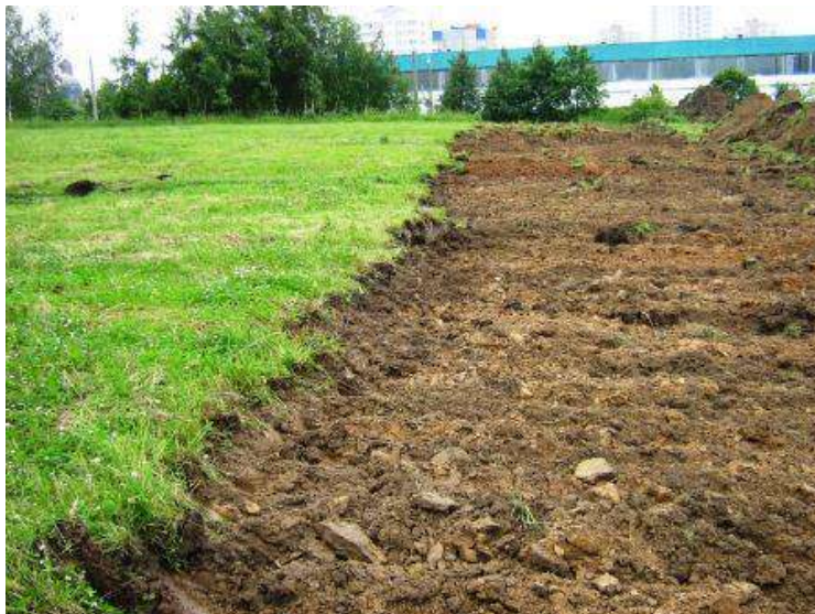
Рисунок 3 – Срезка верхнего плодородного слоя почвы
