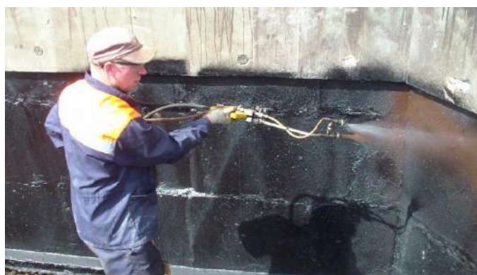
Рисунок 2 – Нанесение резины
