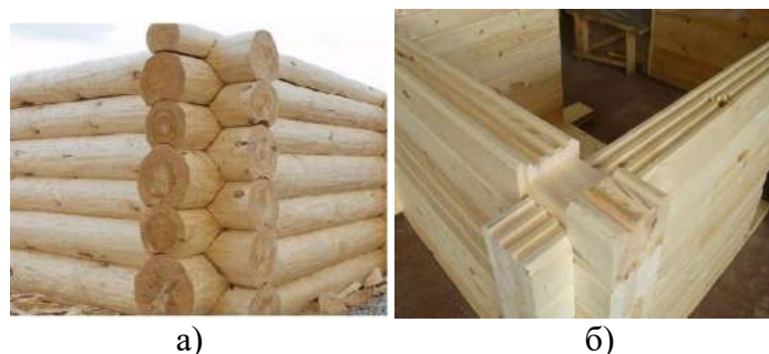
Рисунок 1 – Строительные элементы из массивной древесины: а) оцилиндрованные бревна; б) профилированные брусья
