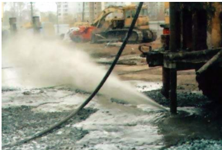
Рисунок 1.4 – Высоконапорная струя цементного раствора
