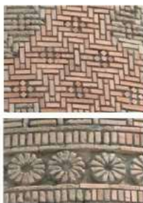
Укладка кирпича в технике Хазар-баф: (Перс. Тысяча переплетений) Текстильный термин, в кирпичной архитектуре для обозначения тканого, шахматного качества кирпичного убранства
