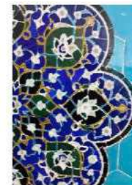
Кашинная мозаика (Мозаичный фаянс) узорчатая композиция из плотно прилегающих небольших кусочков плитки, поверхность которых покрыта глазурью разного цвета
