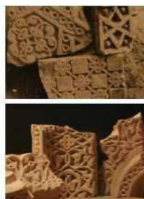
Укладка кирпича в технике Хазар-баф: (Перс. Тысяча переплетений) Текстильный термин, в кирпичной архитектуре для обозначения тканого, шахматного качества кирпичного убранства
