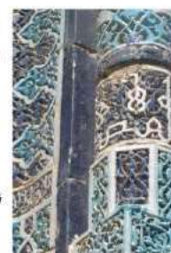
Резная терракота: Декоративная техника в которой во влажных кирпичиках терракоты перед обжигом вырезаются трехмерный геометрический или растительный орнамент
