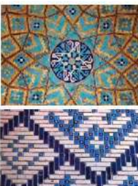
Глазурирование кирпича в технике Бана'и: (Перс. Строительная техника) Облицовка одноцветных глазурованных кирпичей, уложенных внутрь неглазурованных, образующих геометрический узор
