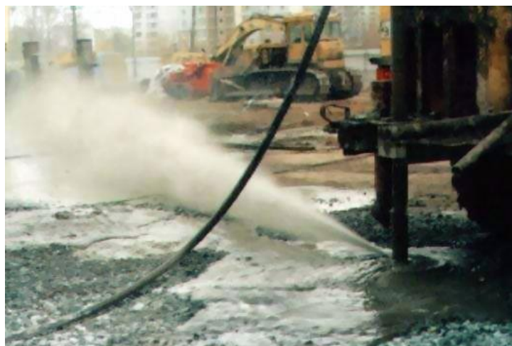
Рисунок 1.4 – Высоконапорная струя цементного раствора
