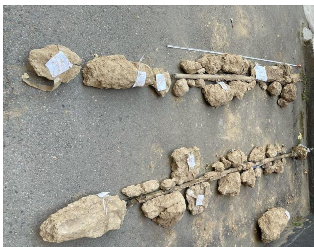
Рисунок 2.16 – Вид изъятых из грунта анкеров при полевых испытаниях Данные по расходу двухкомпонентной смолы на каждый анкер:
