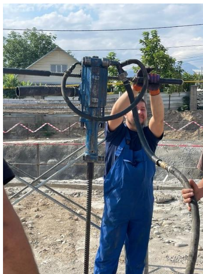
Рисунок 2.14 – Процесс бурения пневматического бурильного молотка с реверсом марки Permon VKS 80
